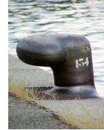
Bollard (à quai)
